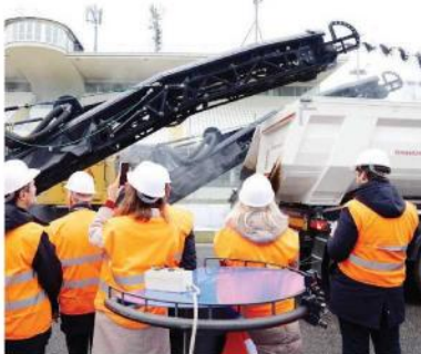
L'avvio dei lavori di ammodernamento all'Autodromo ANSA
